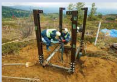
水釜北東データ中継点での太陽電池パネル架台更新作業。
